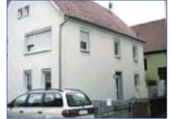
Kirchheim/Neckar Baujahr 1920, EFH komplett renoviert mit ca. 174 m 2 Wfl., großes Grundstück mit 536 m 2 Fläche, Dachterrasse, Scheune, weitere Ausbaureserven. € 219.000,- *)
