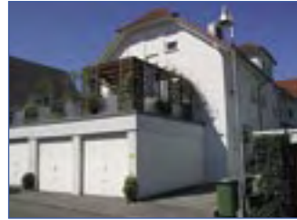
Bönnigheim EFH, Baujahr 1997 mit ca. 118 m 2 Wfl. Doppelgarage Zugang zum Haus, große Dachterrasse, ruhige Wohnstr. € 270.000,- *)
